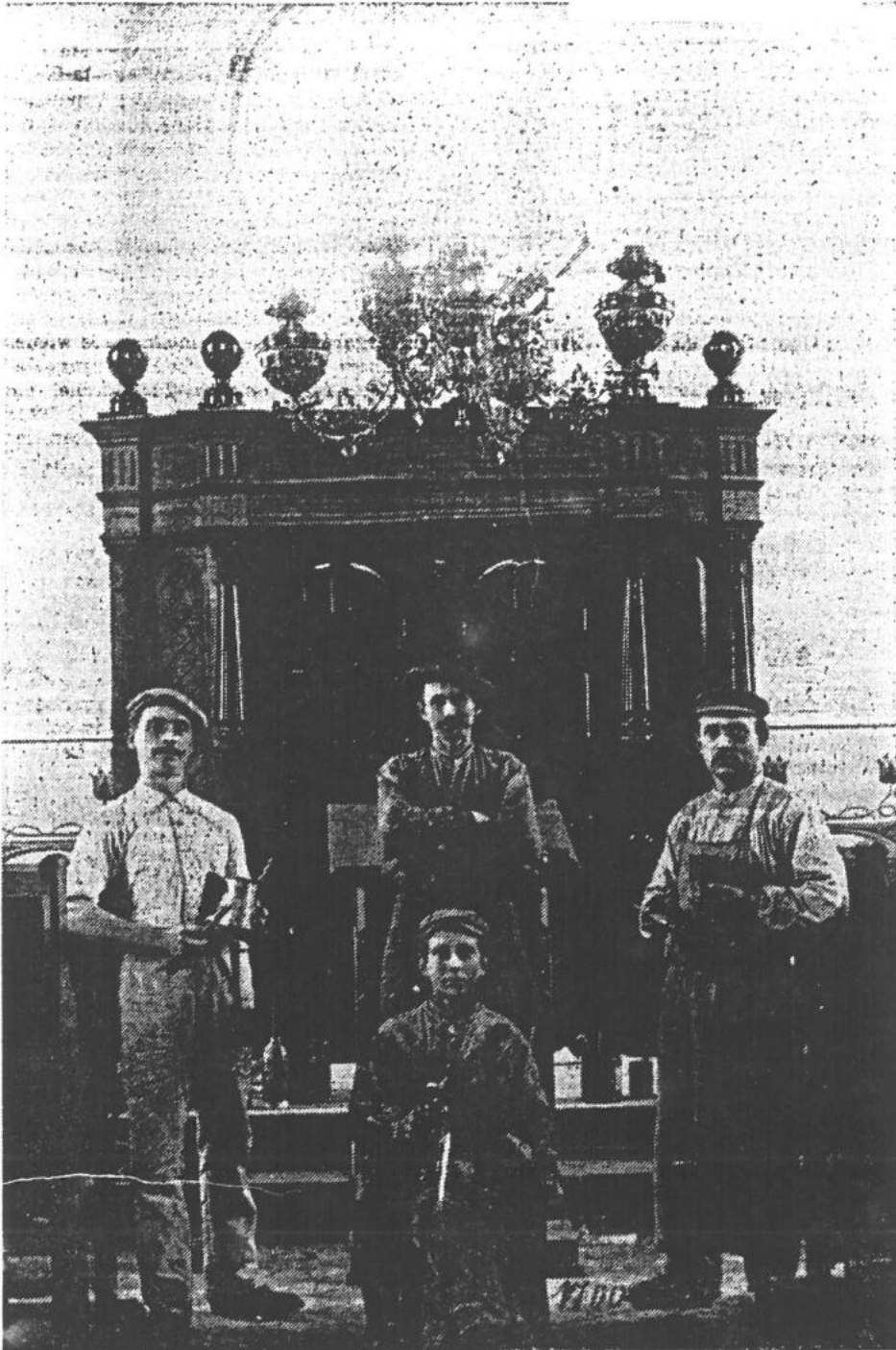
Nach Fertigstellung der Bauarbeiten an der neuen Synagoge in Nastätten ließen sich diese Handwerker aus der Stadt vor dem Altar fotografieren. Die Aufnahme läßt zugleich erkennen, daß die jüdischen Mitbürger damals voll in der Bevölkerung integriert waren. (Historische Bildersammlung Helmut Steeg, Nastätten). Reproduktion: E. Hofmann
