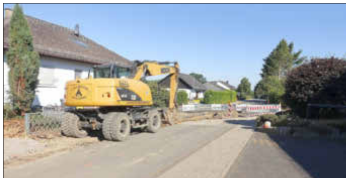
An der Kreuzung Wilhelm-Nesen-Straße/ Sauerbornsweg beginnen die Arbeiten an der Wasserleitung
