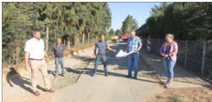
Beim Besprechungstermin an der Baustelle Fotos: Winfried Ott
