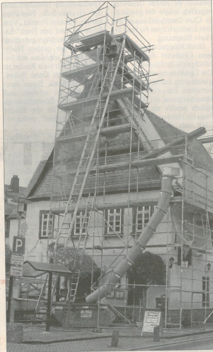
Schwindelfreie Handwerker sind derzeit dabei, das altehrwürdige Alte Rathaus in der Römerstraße in Nastätten umfassend zu sanieren. ■ Foto: Winfried Ott
