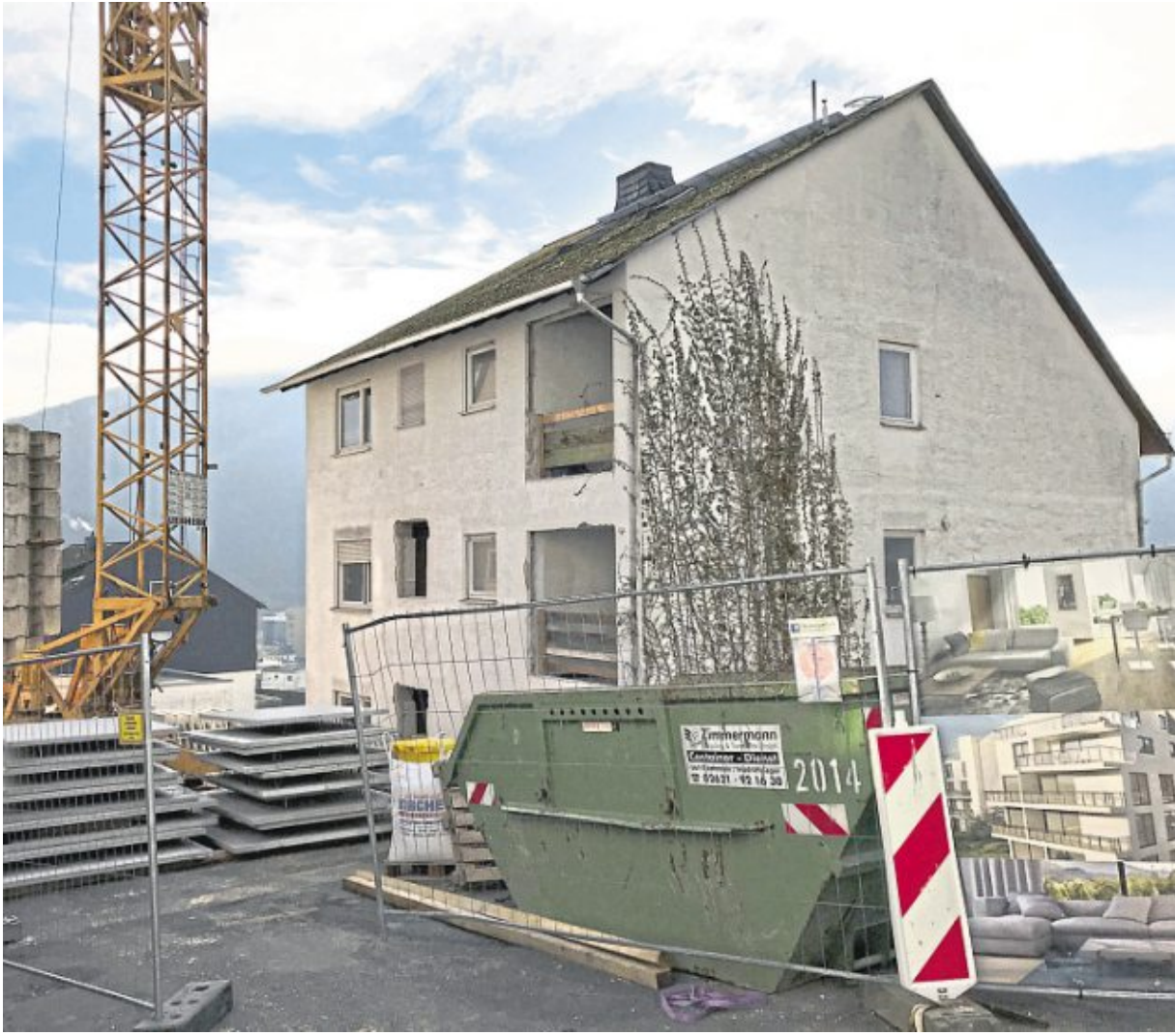
Wie in anderen Teilen der Stadt sorgt auch im Steinbichlerweg ein Privatinvestor für Wohnraum. Das Bestandsgebäude wird saniert, die sechs Wohneinheiten darin auf fünf reduziert. Ein neues Haus mit drei Wohneinheiten wird rechts angebaut.
