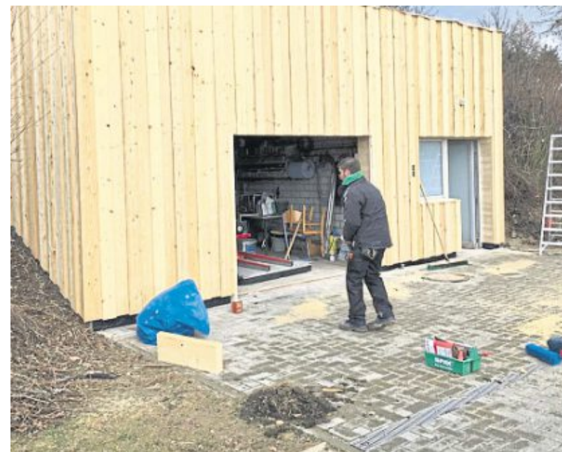
Auch das Betriebsgebäude der Sportanlage ist inzwischen saniert. In den nächsten Wochen werden noch die Grünanlagen gestaltet. Foto: privat
