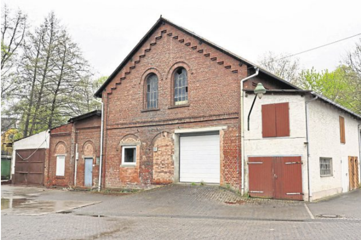
Apropos Stadtentwicklung: Der Backstein darf bleiben am ehemaligen Gaswerk in Nastätten, die helleren Anbauten werden jedoch abgerissen. Foto: Thorsten Stötzer
