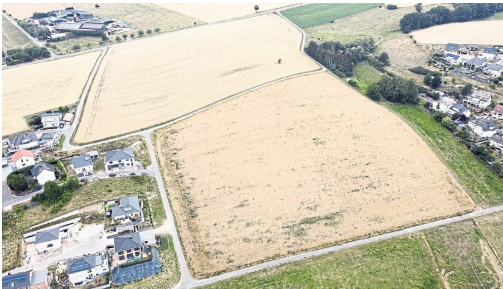
Auf dem freien Feld unten in der Mitte soll der zweite Teilbereich des Neubaugebiets Weiberdell entstehen, links unten soll die Kindertagesstätte gebaut werden. Links daneben ist der erste Abschnitt des Baugebiets zu sehen, rechts stehen die ersten Häuser der Gemeinde Buch. Foto: Stadt Nastätten
