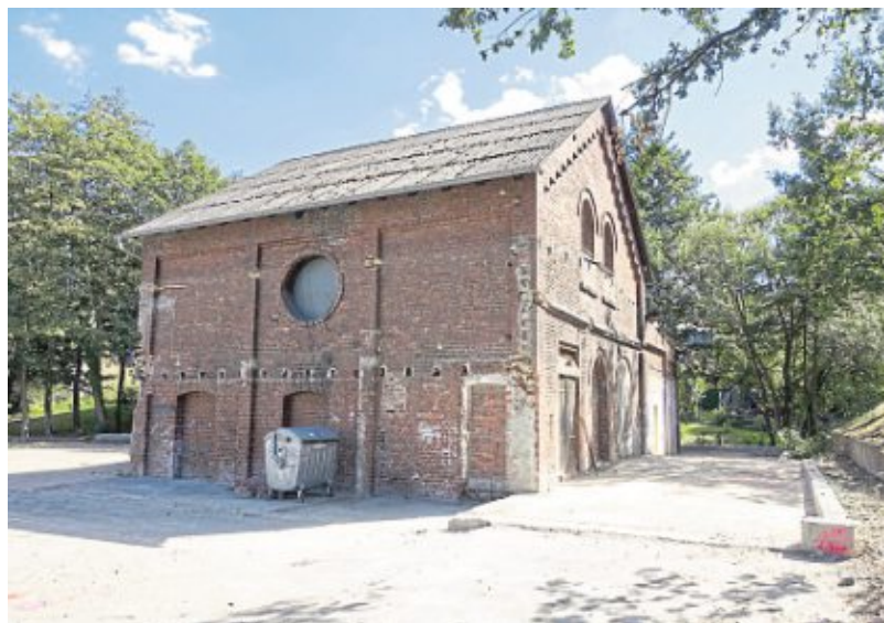
Motto bei der Umgestaltung: Der Backstein darf bleiben, und erhalten wird ebenso das sogenannte Köhlerhaus. Die helleren Anbauten mussten hingegen weichen.
