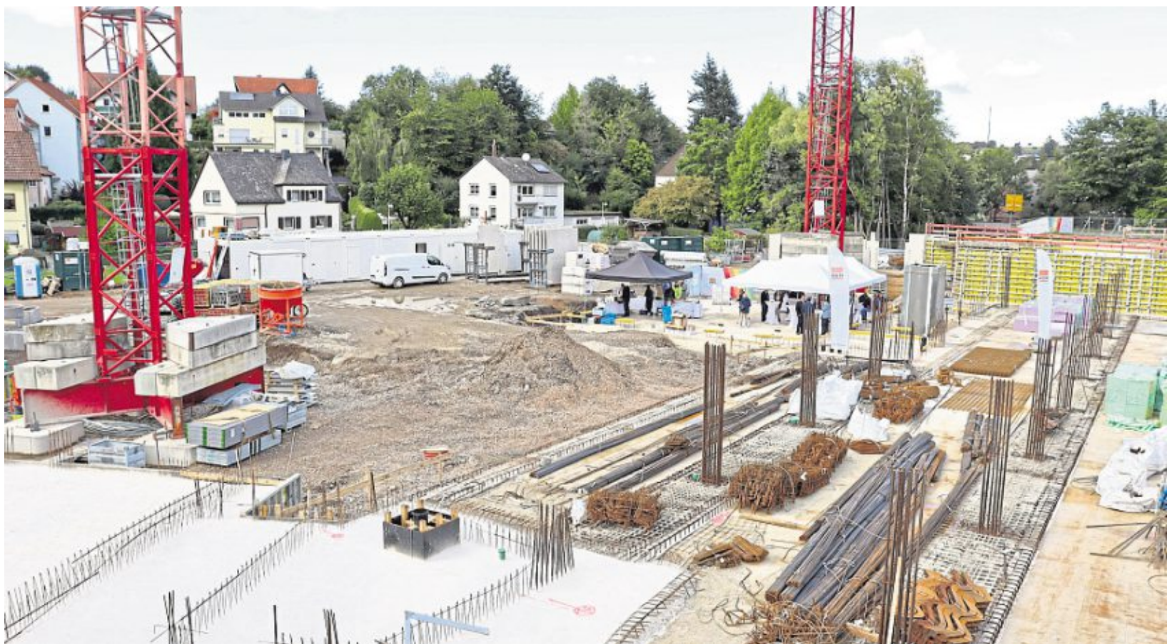
Eine riesige Baustelle tut sich derzeit in Nastätten auf, wo der Seniorenwohnpark entsteht.
