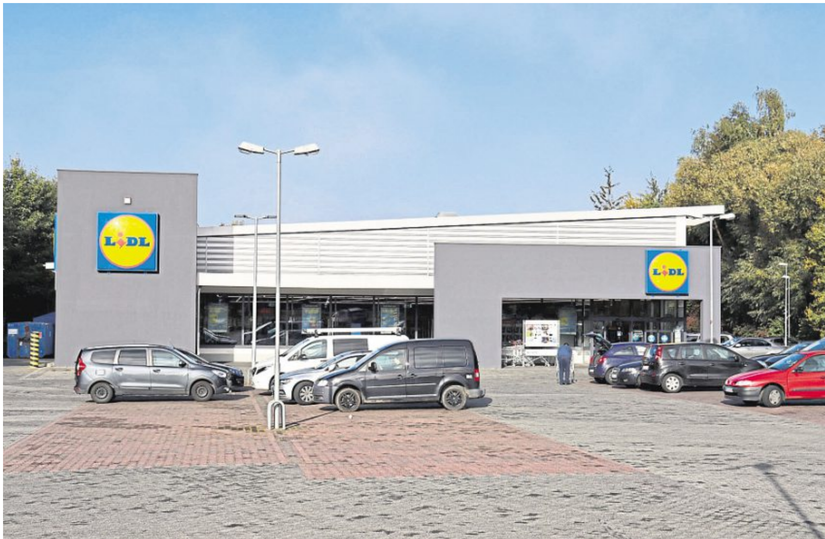
Am vorhandenen Standort in Nastätten soll der Lidl-Markt durch Abriss und Neubau wachsen.
