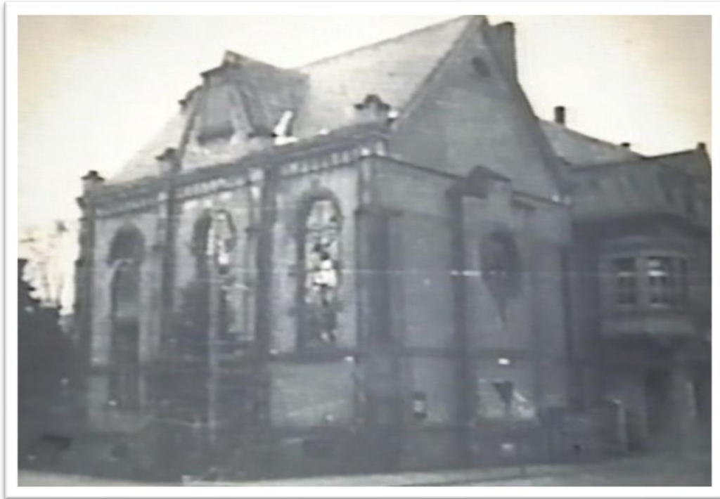
Die schwer beschädigt Synagoge nach der Reichspogromnacht 1938. Der auf dem Giebel, hoch über der Straße angebrachte Davidstern (heller Fleck) wurde demontiert.
